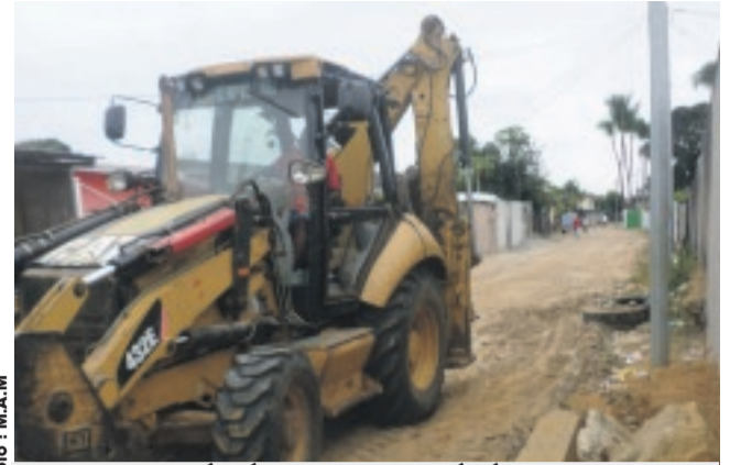
Alexandre Désiré Tapoyo a procédé au lancement des travaux de terrassement de la voie menant à l'école publique d'Alibandeng.
