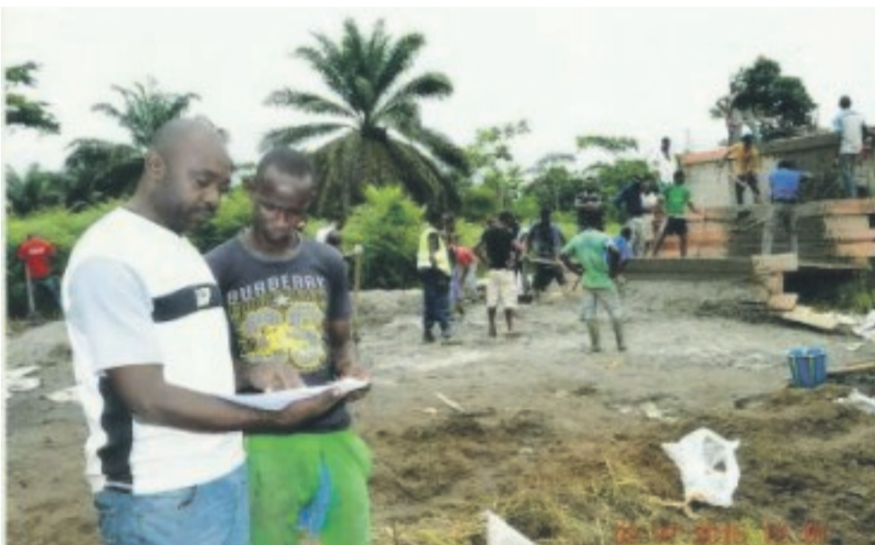
L'entrepreneur Michel Nguema Nkizo'o s'active à livrer le chantier dans les délais impartis.
