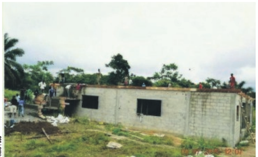
L'un des bâtiments en construction : les travaux vont bon train.
