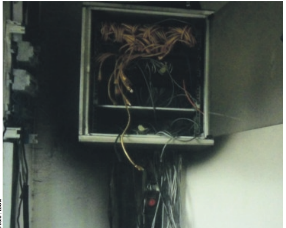
Le compteur à l'origine du court-circuit ayant entraîné l'incendie de la salle informatique.
