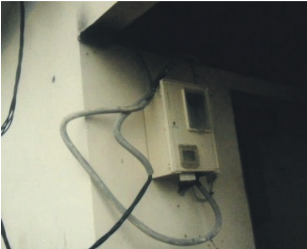
Le compteur à l'origine du court-circuit ayant entraîné l'incendie de la salle informatique.
