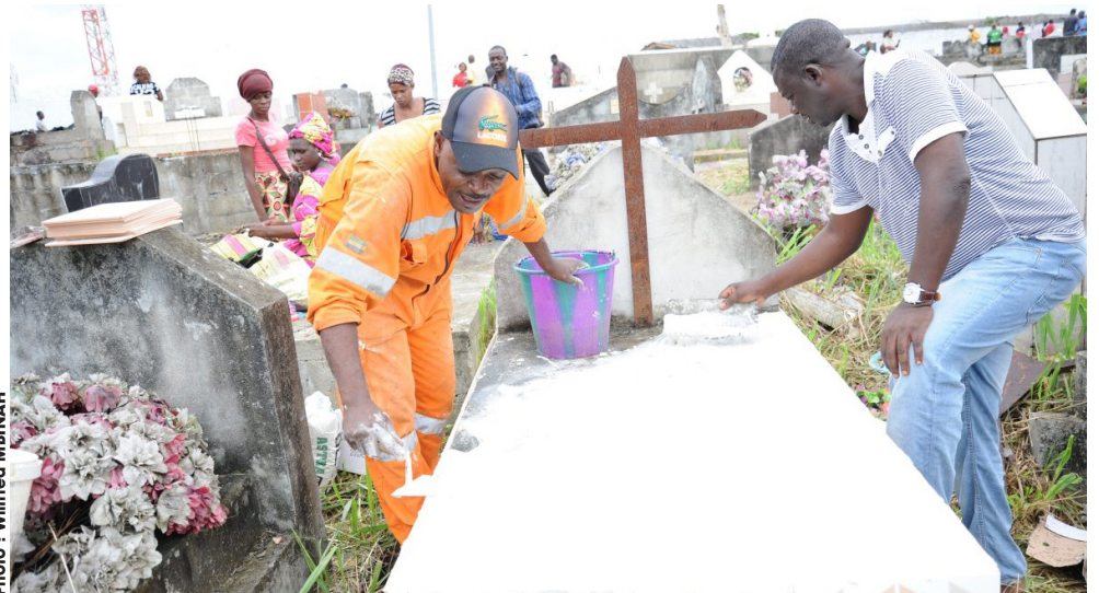
C'était aussi l'occasion de réaliser quelques travaux, comme le carrelage d'un sépulcre.
