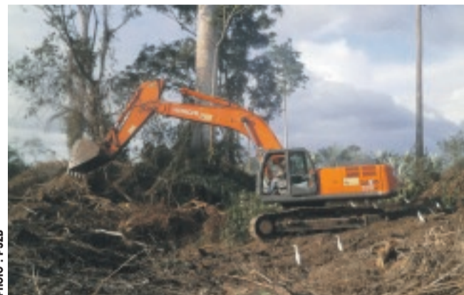
Photo : PSZB Un engin lourd à pied d'oeuvre pour la déforestation.
