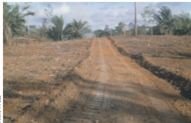
Photo : PSZB Les voies d'accès sont déjà encours d'aménagement.
