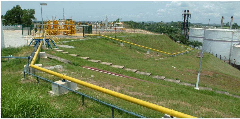
Les installations de la SEEG vont subir une maintenance complète.
