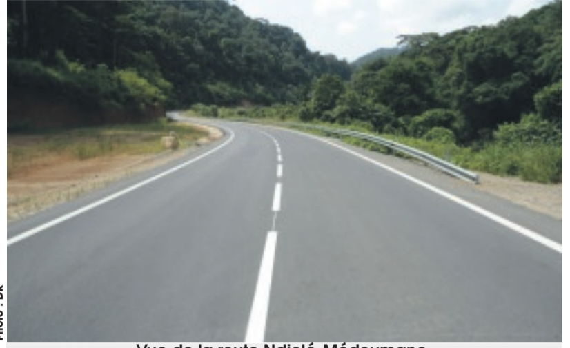
Vue de la route Ndjolé-Médoumane.
