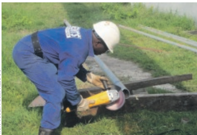
Un ouvrier à l'œuvre sur un site.
