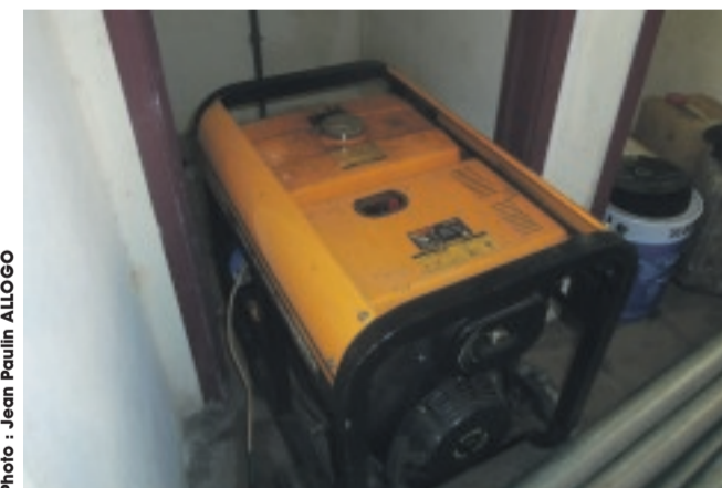
Le poste à souder qui permet de réaliser les ouvrages.
