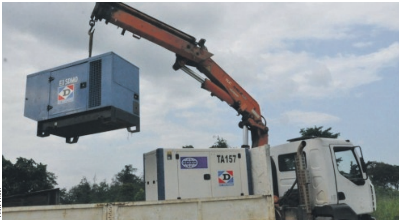
Le débarquement d'un groupe électrogène dans un village entre Ndjolé et Medoumane.
