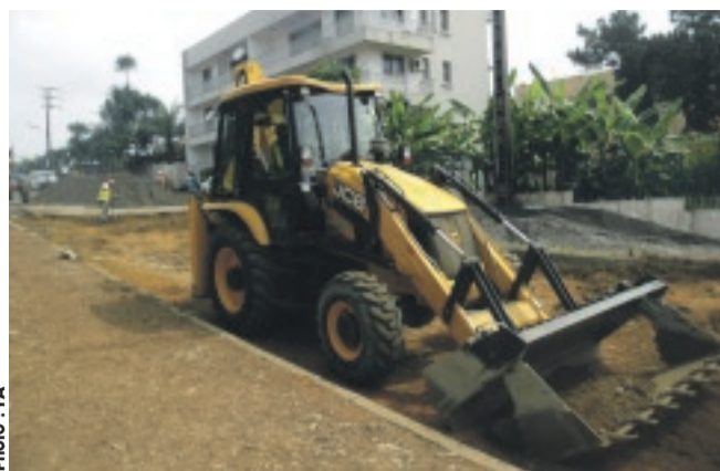
Le traitement des crevasses par un engin de Colas...
