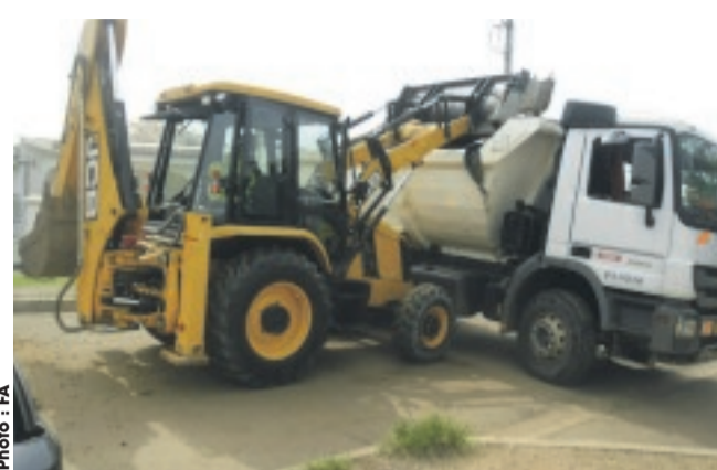
La Tractopelle remplissant le camion de terre.
