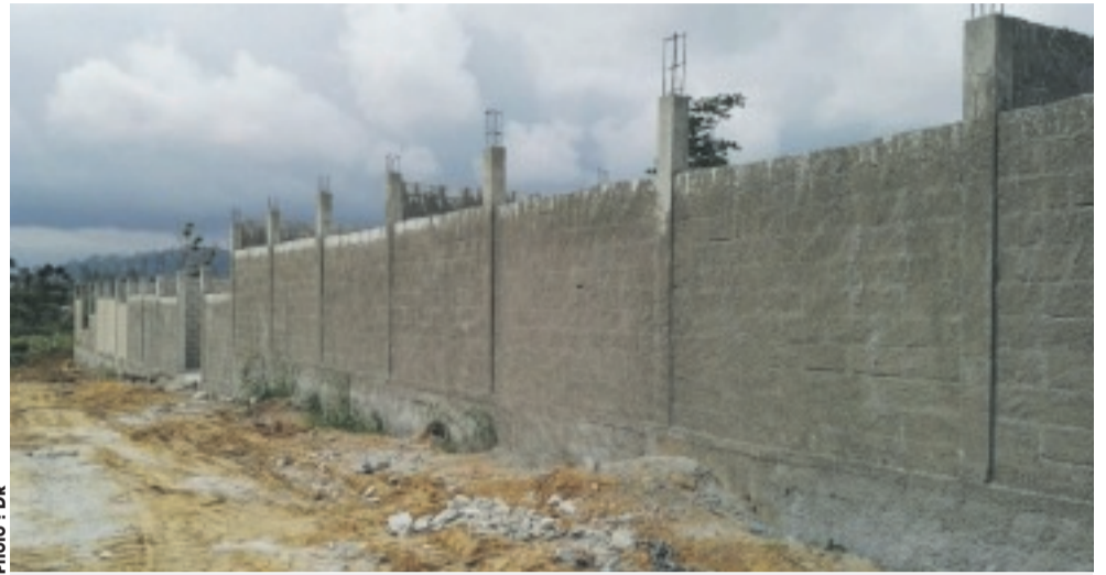
La barrière du futur CES est déjà sortie de terre.
