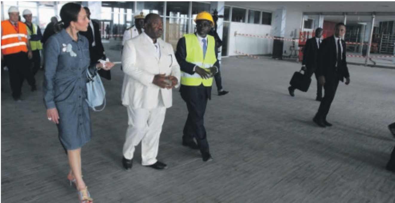
Une phase de la visite du chantier du nouvel aéroport.
