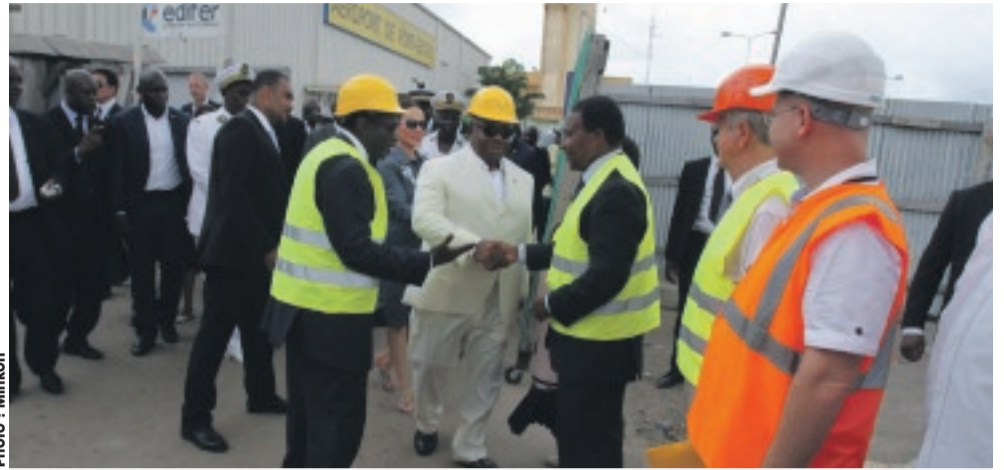
Le chef de l'Etat accueilli au chantier du nouvel aéroport de Port-Gentil.
