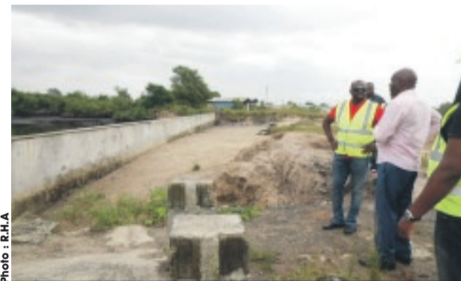
Fabrice Andjoua Bongo Ondimba suivant les explications du chef de chantier du quai de la marine Kiliba.
