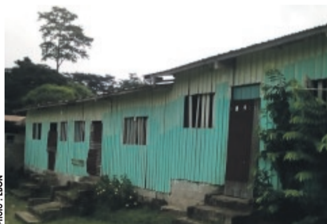
Une vue des salles de classe. L'ensemble des installations ont été mises sous scellés
