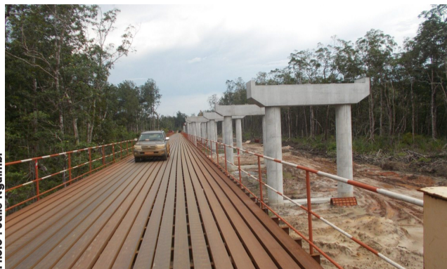
A côté des ponts métalliques poussent les ouvrages définitifs
