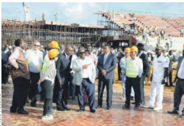
Ici, sur le chantier du futur stade d'Oyem.
