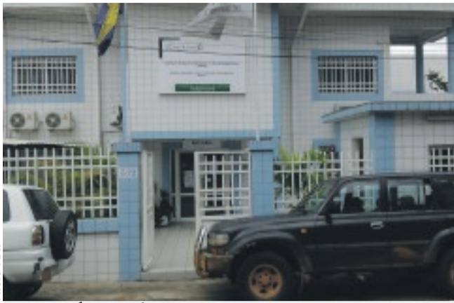
L'entrée du bâtiment abritant les locaux du Smur CNSS au centre-ville.
