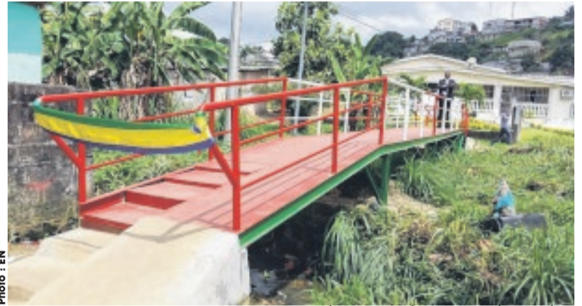
Cet ouvrage de Adzebe-Sibang va désormais réduire la pénibilité du passage de ce cours d'eau.
