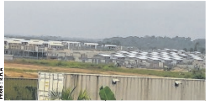
Une vue des différents logements en construction.
