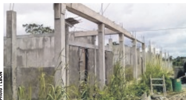
L'arrêt des travaux de construction du CES dans leur quartier suscite l'indignation des habitants de la bourgade.
