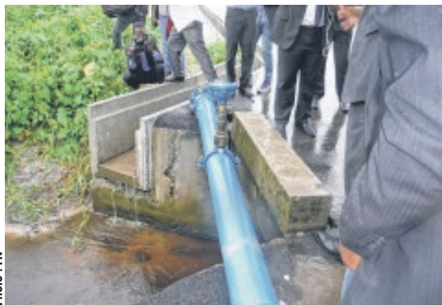
Le quartier " Les 100 Manguiers " est désormais ravitaillé en eau.
