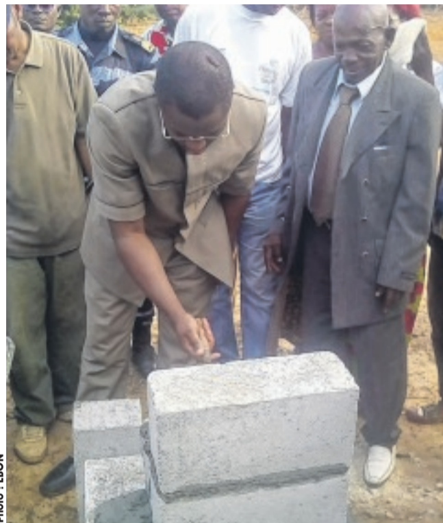
Une phase de la pose de la première pierre par le ministre Gwodock.
