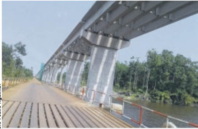
Deux ponts qui doivent....
