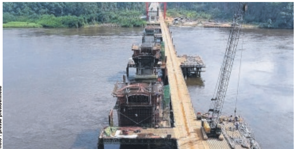
Une vue aérienne du futur pont Ozouri.
