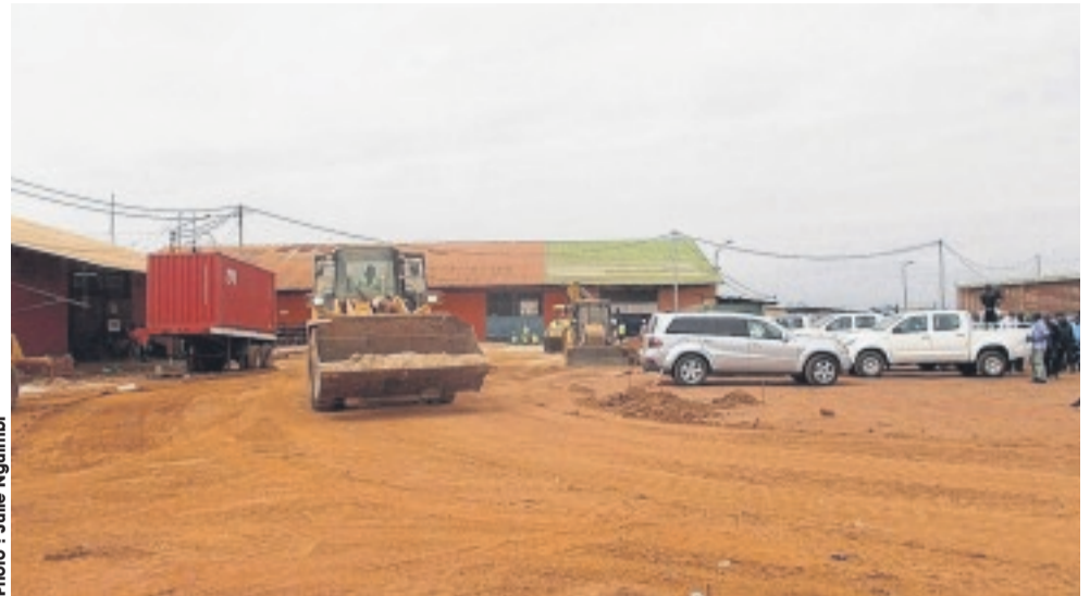
La plate-forme du port môle en chantier.
