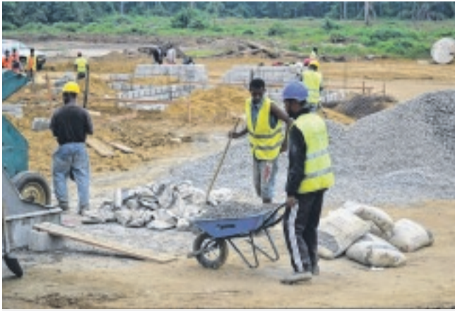
Des travailleurs en pleine activité sur le chantier.
