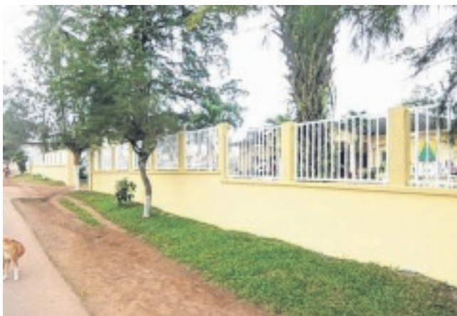
L'édifice désormais entouré d'une barrière.
