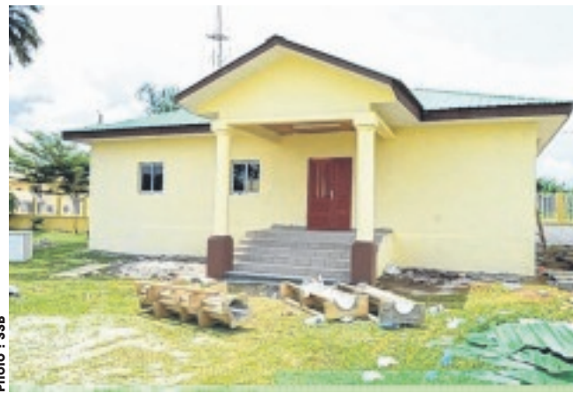
Le bâtiment tenant lieu de foyer est fin prêt.
