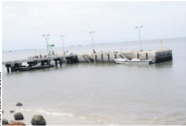
Une vue des installations du centre de pêche d'Oloumi.
