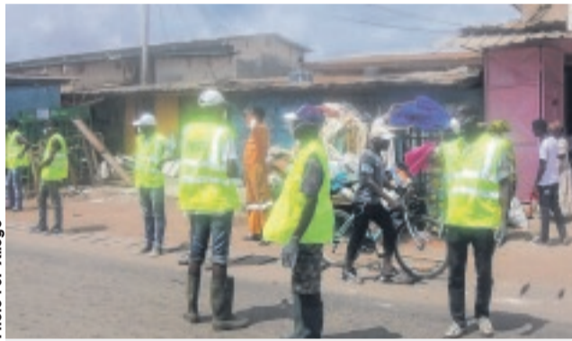
Les ouvriers sur le chantier.
