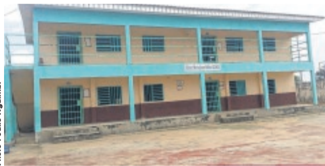
Un nouveau bâtiment au lycée Raponda Walker.
