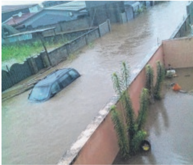
Une voiture complètement engloutie dans les eaux.
