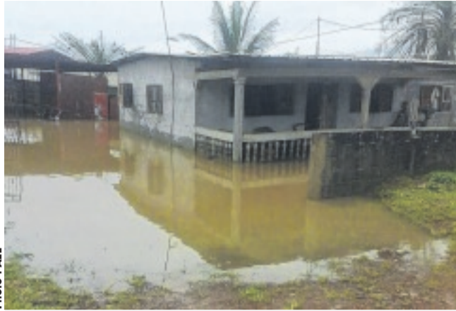
Une maison inondée à Akanda, hier...
