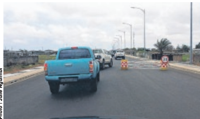
... la route Forasol/Mbega dont les travaux sont achevés...
