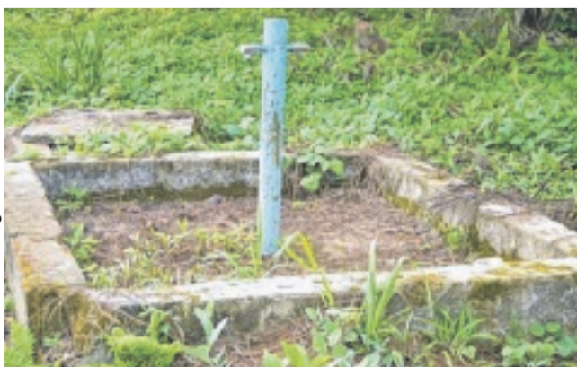
L'installation inachevée d'une fontaine.
