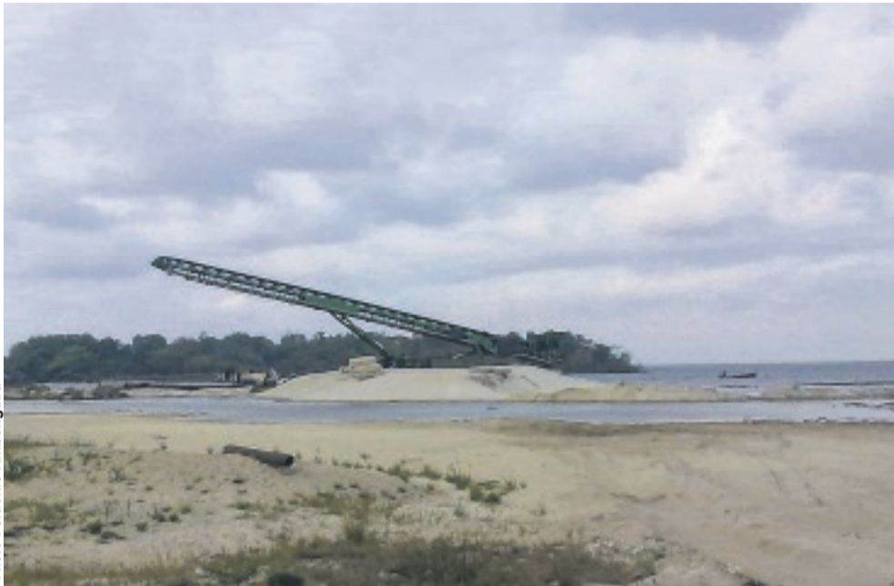
L'activité est destructrice de l'environnement.
