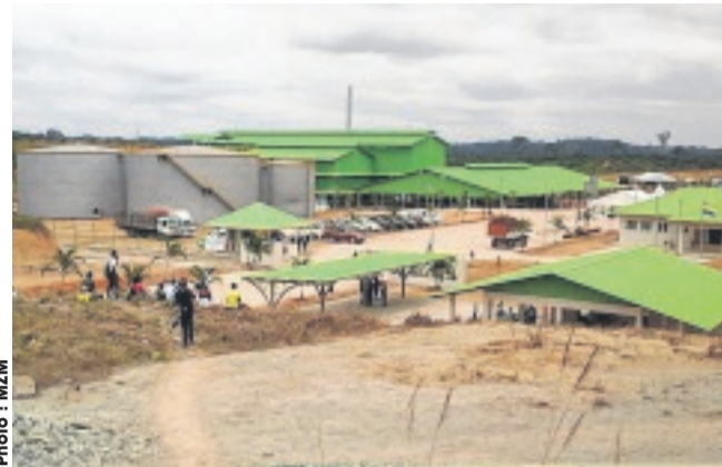
Les installations de l'usine Awala d'Olam, près de Kango.
