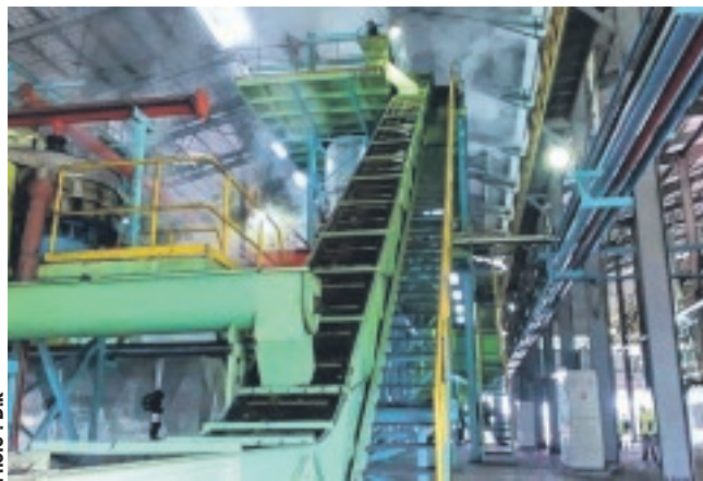
Une vue de l'usine de Mboukou à Mouila.
