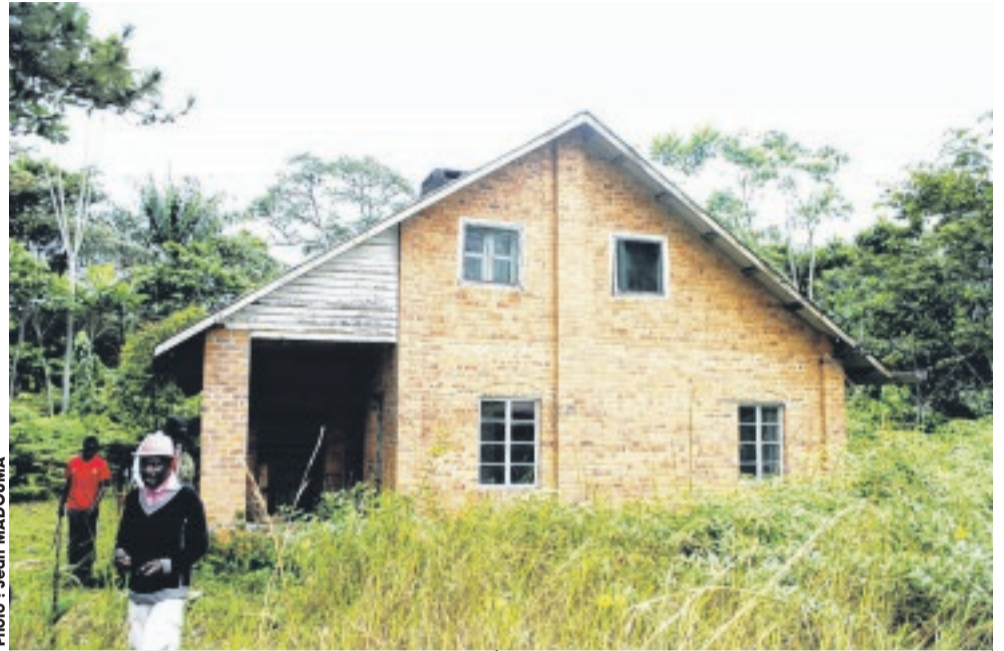
Cette maison date de 1948. Des opérateurs l'entretiennent dans le cadre d'un projet touristique en gestation.
