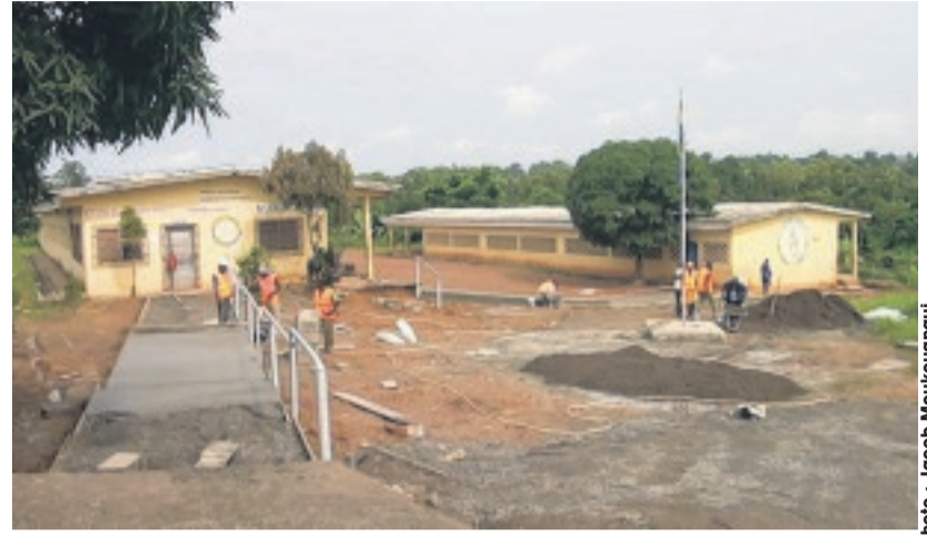
... observant les ouvriers en activité sur le site de l'école.
