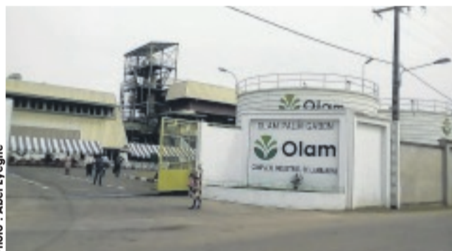
Une vue de l'usine d'Olam Palm Gabon de Lambarené.
