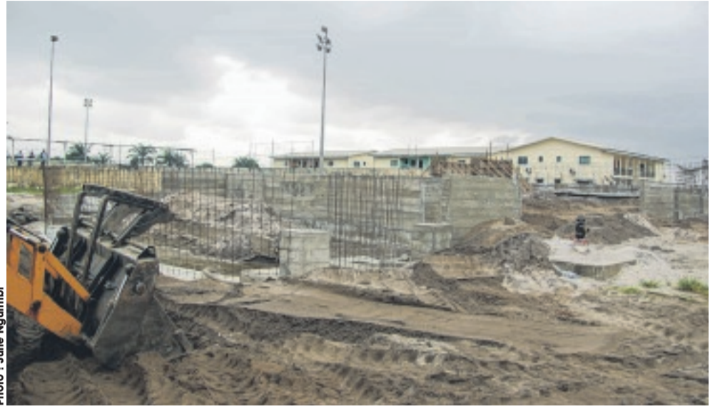
Le chantier de construction de Canal Olympia dont les ouvrages sortent de terre.
