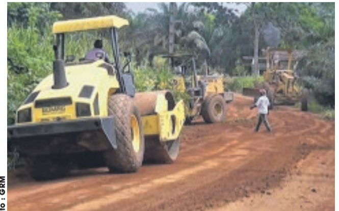
Les engins en train de reprofiler la voie de communication du quartier Didjanou.
