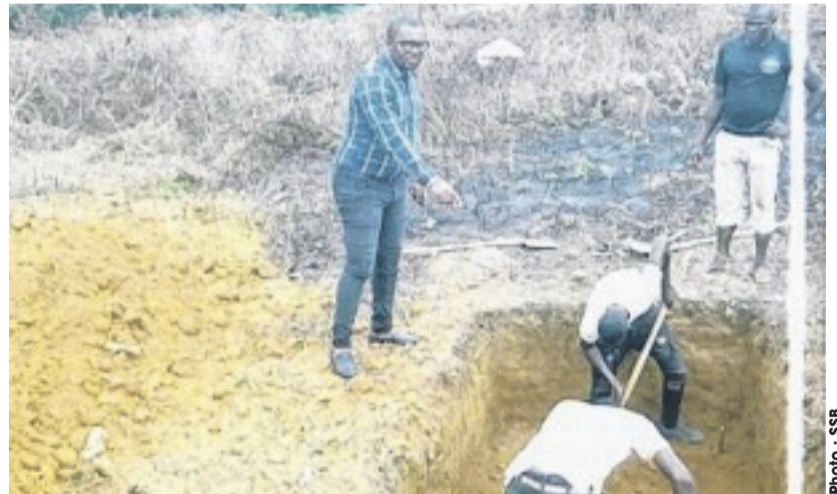
Après deux mois de travaux exécutés par l'Ajev,...
