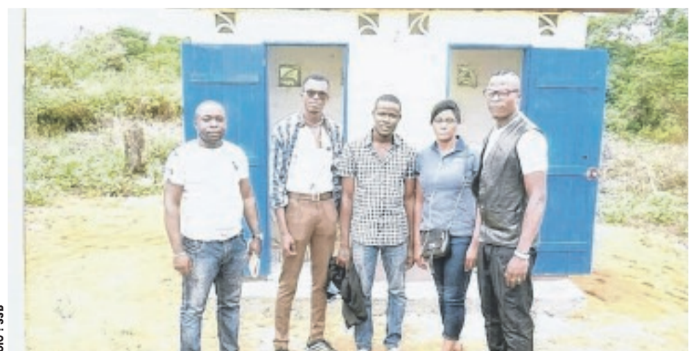
... le lycée Jésus-Marie dispose enfin de latrines modernes, ici réceptionnées par les représentants de la coopérative.
