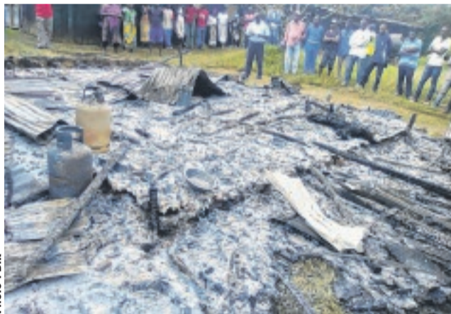
L'explosion du gaz a contribué à intensifier le brasier.
