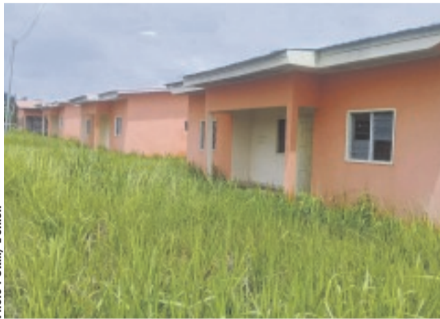
Une vue des logements inachevés de Bikélé.
