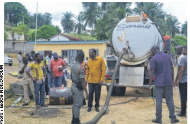
... avant de faire procéder à la vidange des fosses septiques de la maison d'arrêt.
