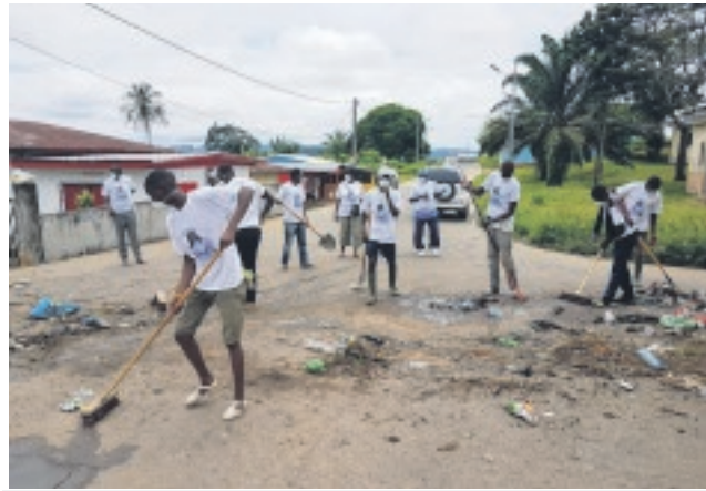
... et nettoyage des chaussées.
