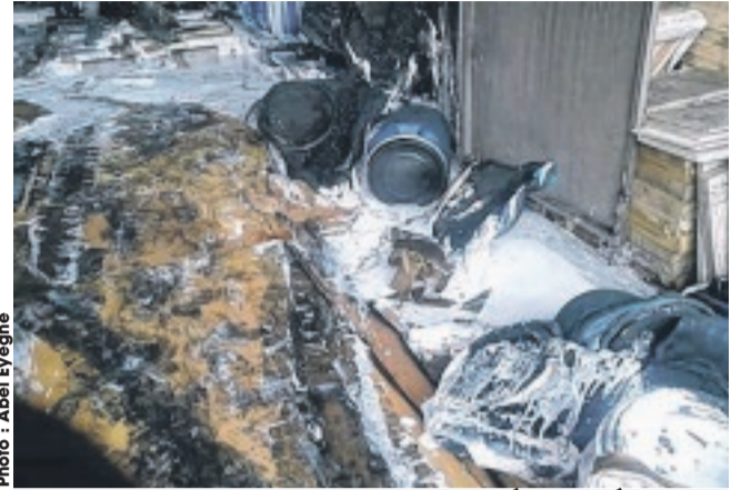
Les pots de peinture n'ont pas échappé aux flammes.
