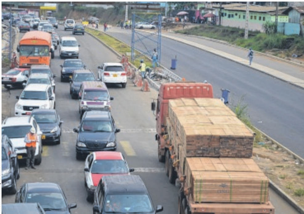
En ce moment, le laboratoire est engagé dans les travaux de la route PK 5-PK 12.
