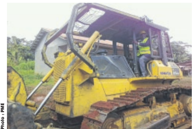
... avant qu'il ne lance les travaux, juché sur cet engin.
