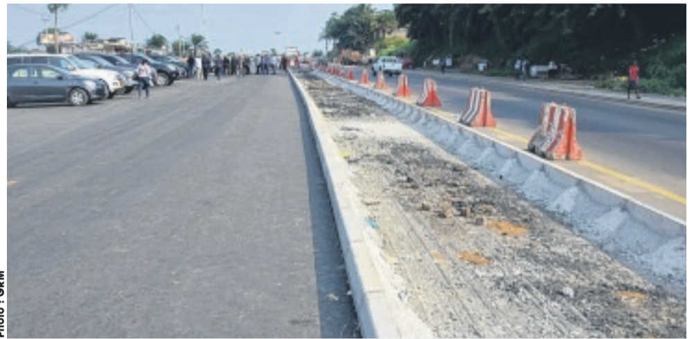
Près de 85% des travaux de l'axe PK5-PK12 sont achevés.
