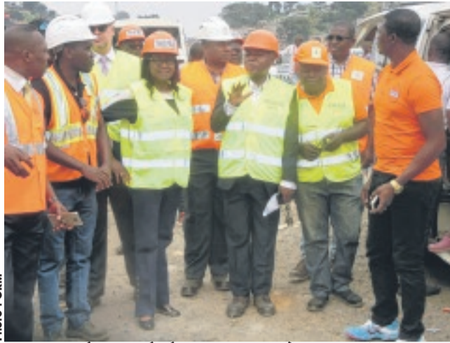
La secrétaire générale du ministère des Infrastructures, Yolande Nyonda, lors de sa visite du chantier.
